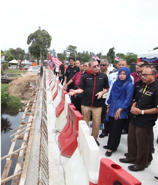
Tinjauan kerja pembinaan jambatan
