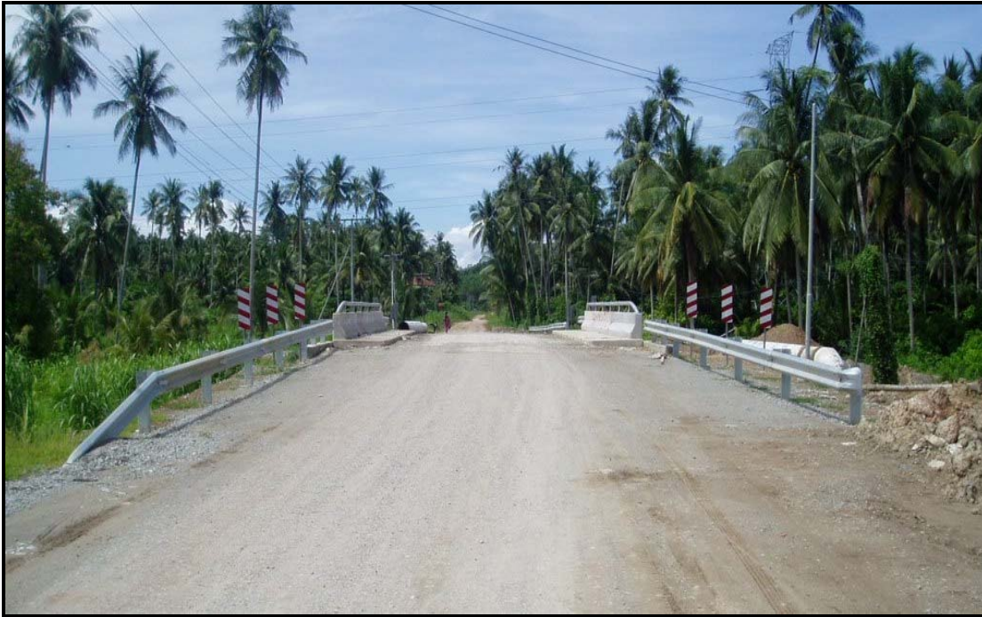
Sub-Pakej 4 - Sg. Karang Bridge, Kudat
