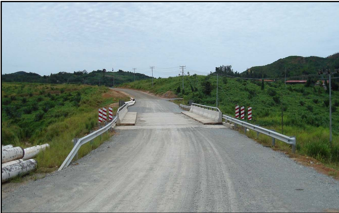
Sub-Pakej 4 - Sg. Pinawantai Bridge, Kudat
