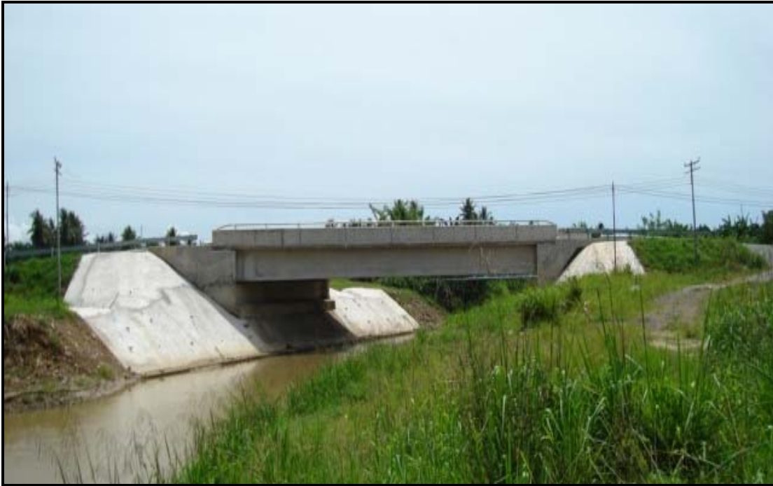
Sub-Pakej 4 - Sg. Rasak Bridge, Kota Marudu
