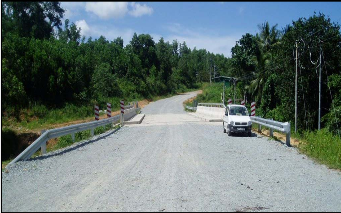
Sub-Pakej 4 - Sg. Bodu Km 2.85 Bridge, Kudat
