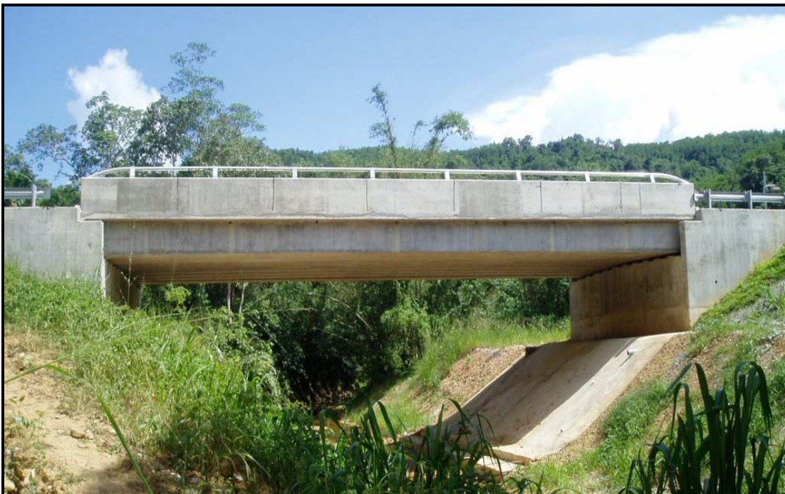
Sub-Pakej 4 - Sg. Bodu Km 4.40 Bridge, Kudat
