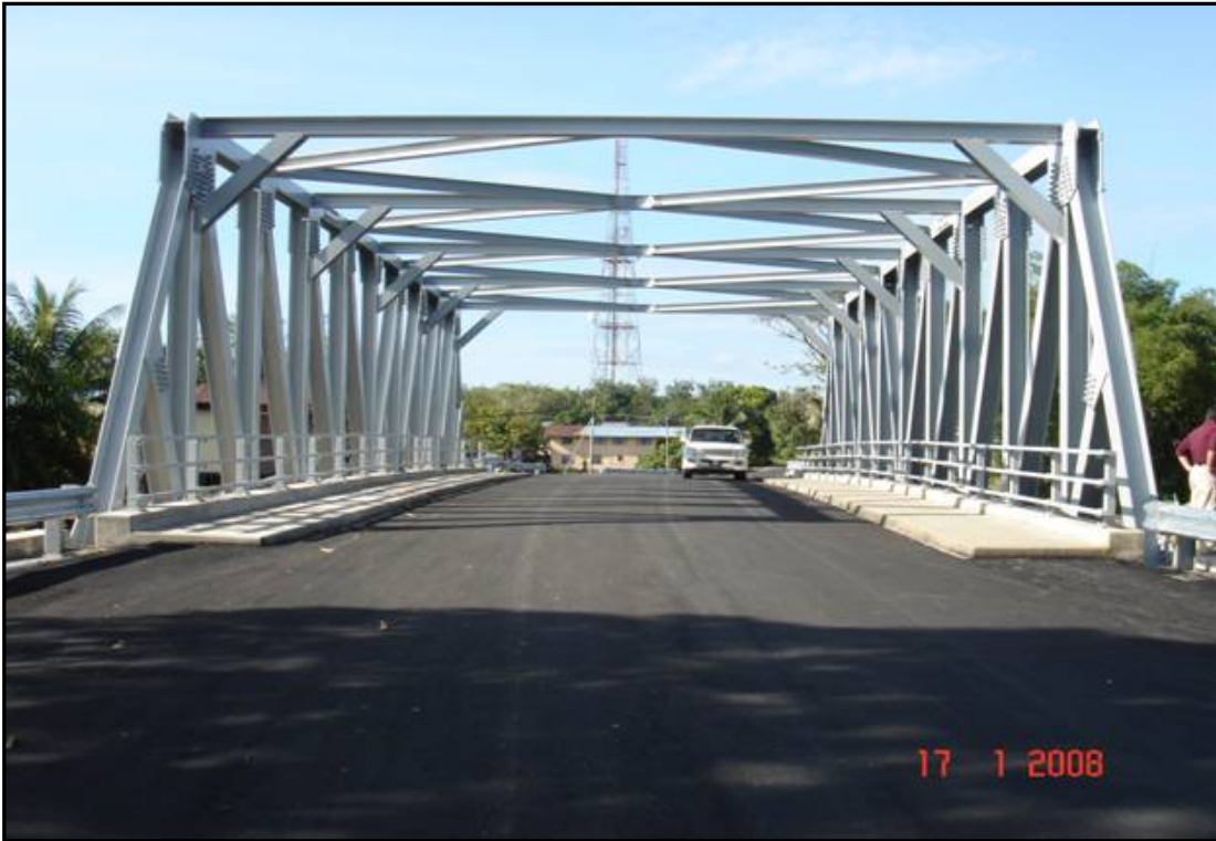
Sub-Pakej 5 - Ulu Bongawan Bridge, Papar
