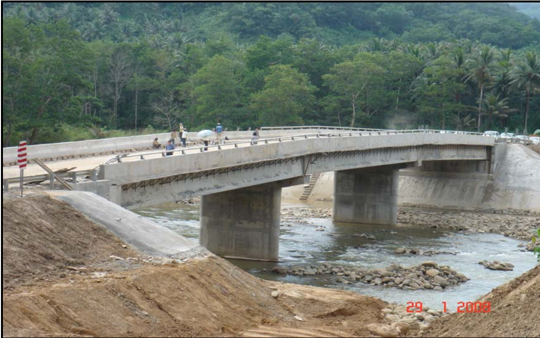
Sub-Pakej 4 - Sg. Samparita Bridge, Kota Marudu
