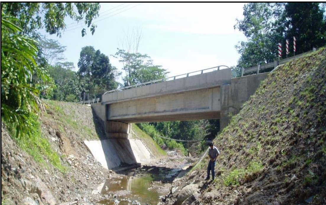
Sub-Pakej 4 - Sg. Karamoko Bridge, Kota Marudu
