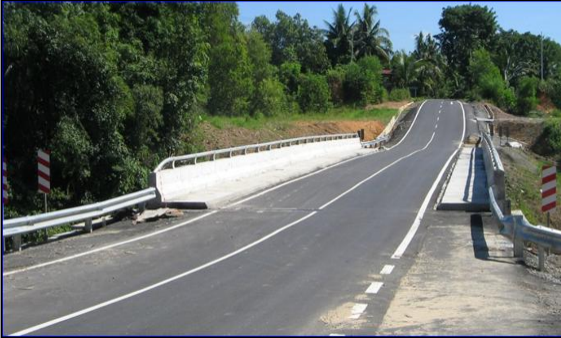
Sub-Pakej 5 - Duvanson Bridge, Kota Kinabalu
