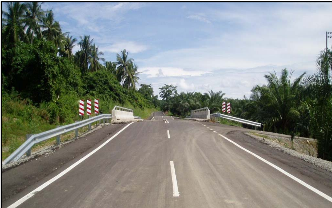
Sub-Pakej 4 - Sg. Tai Cheong Bridge, Kudat
