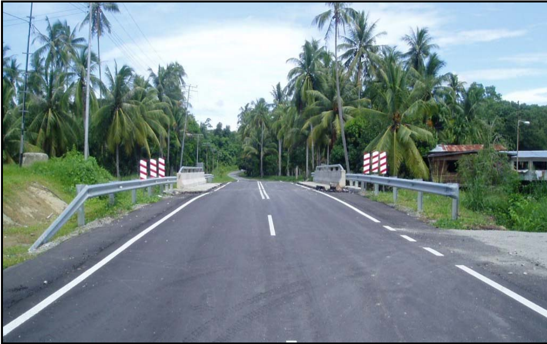
Sub-Pakej 4 - Sg. Agong Agong/Bak Bak Bridge, Kudat
