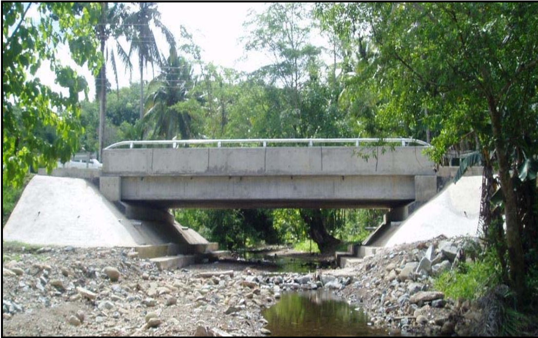
Sub-Pakej 4 - Sg. Mirod Mirod Bridge, Pitas
