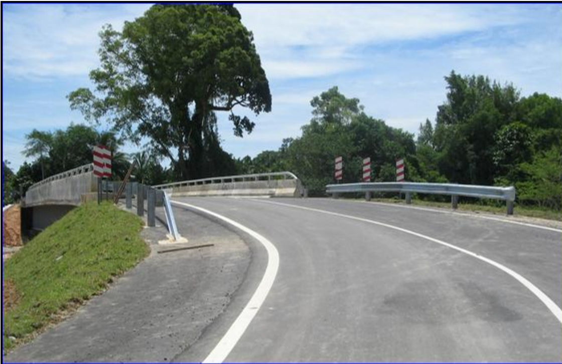
Sub-Pakej 5 - Gadong Bridge, Papar
