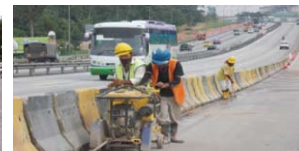
Kerja-kerja pemotongan turapan di lorong kecemasan
