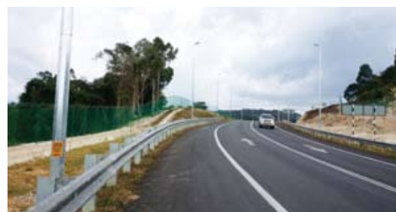
Pandangan dari Jambatan Pandaruan menghala ke ICQS Pandaruan
