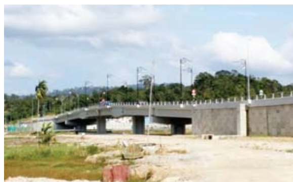
Jambatan Pandaruan dilihat dari sisi
