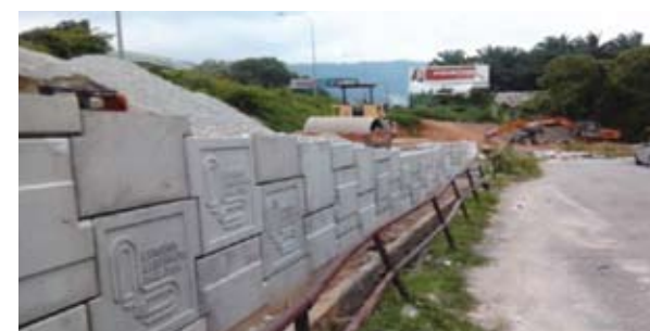
Kerja-kerja pembinaan retaining wall
