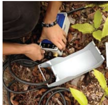
Pemasangan Peralatan Di Tapak
