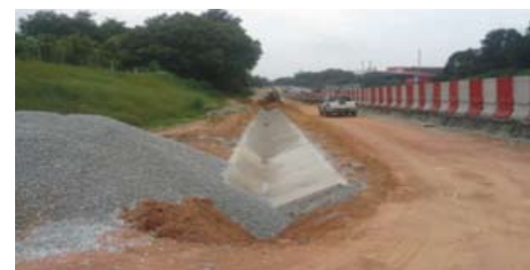
Kerja-kerja pembinaan sistem saliran
