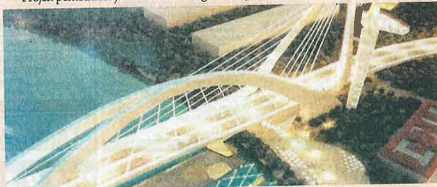
Jambatan ketiga Klang dijangka siap 13 Julai 2016.
