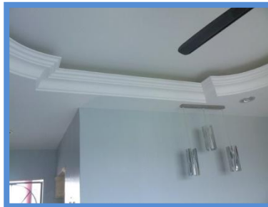
Memasang atau mengganti siling lepa ( plaster ceiling )
