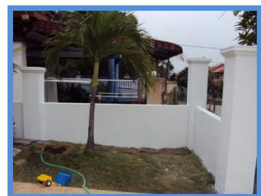
Mengubahsuai pagar dan tembok sedia ada
