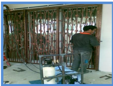
Memasang jeriji besi yang melibatkan kerja-kerja kimpalan 'in-situ' dan bahan pembuangan
