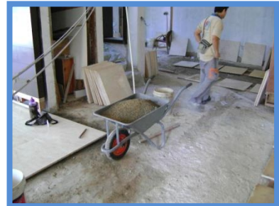
Memasang atau mengganti jubin lantai melebihi daripada 6.5 meter persegi
