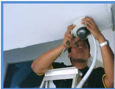
Kerja-kerja pendawaian untuk tujuan CCTV
