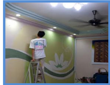
Kerja-kerja mengecat dalam rumah
