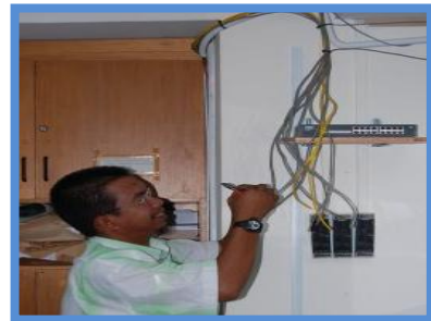
Kerja-kerja pendawaian elektrik
